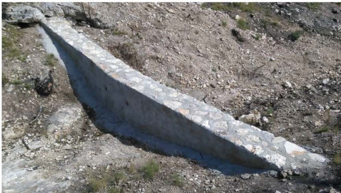
Foto 3: Albarrada tipo de mampostería
