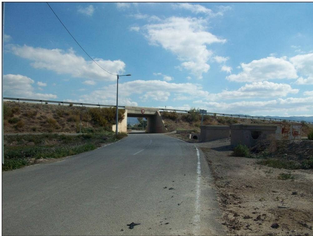
Hinca bajo paso inferior de la Ctra. RM-11.
