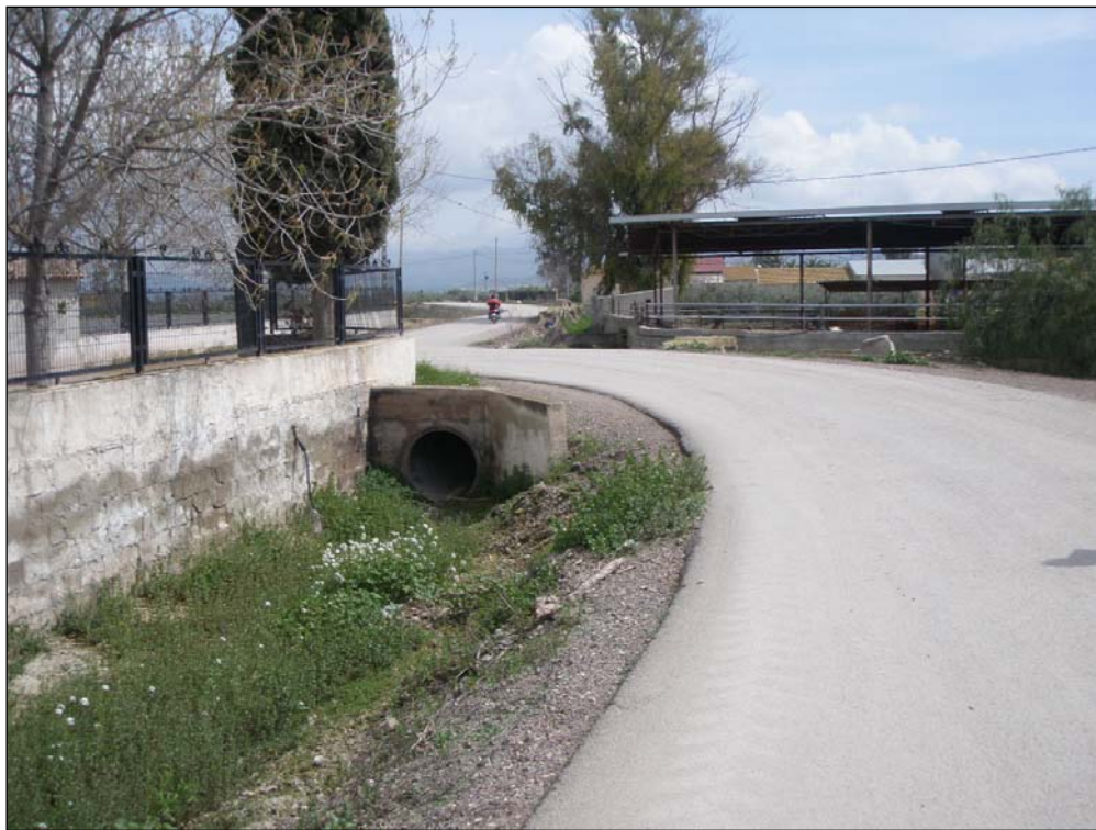
Paso superior sobre acequia de riego entubada.
